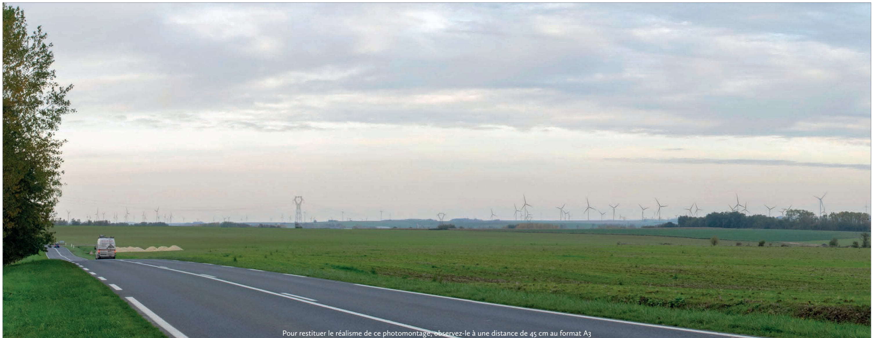
Vue réaliste à taille réelle du projet modifié - Champ visuel horizontal de l'image : 47,5°
